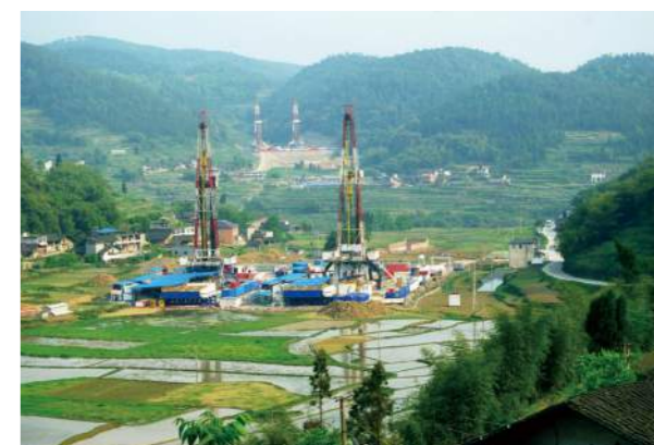
重庆涪陵页岩气田是中国第一个实现商业开发的页岩气田，是除北美以外最大的页岩气田，是中国页岩气勘查开发示范基地和国家级页岩气示范区，截至 2017 年，年均产能已达到 100 亿立方米。
