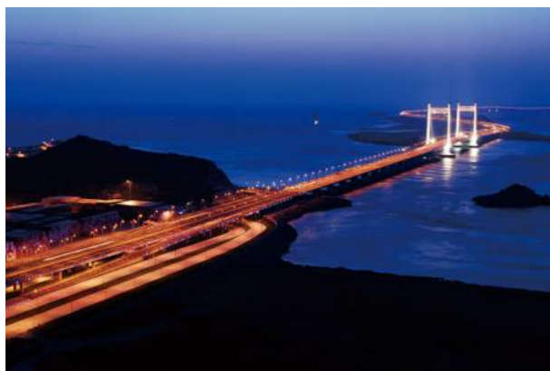
东海大桥起始于上海浦东新区芦潮港,南跨杭州湾北部海域,直达浙江嵊泗县小洋山岛。全长 32.5 公里的东海大桥是上海国际航运中心深水港工程的一个重要组成部分。
