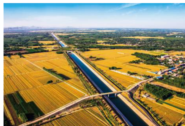
南水北调工程是世界上规模最大的调水工程，通过东、中、西三条调水线路，与长江、黄河、淮河和海河四大江河连通，构成四横三纵、南北调配、东西互济的水网格局，是实现中国水资源优化配置、促进可持续发展、保障改善民生、推动生态文明建设的重大战略性基础设施。图为南水北调中线工程河北段。
