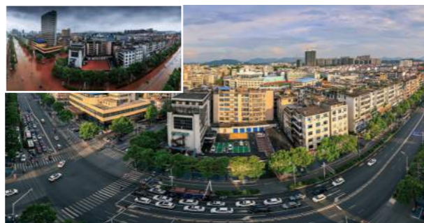
2015年开展海绵城市试点，30个试点城市建设成效显著。图为江西省萍乡市万龙湾片区市政基础设施海绵化改造前后对比，以往“逢雨必涝”的街区实现了“小雨不积水、大雨不内涝”。
