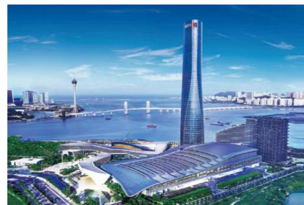
珠海正在推动“二次创业”，打造粤港澳大湾区经济新引擎。图为珠海横琴自由贸易区。
