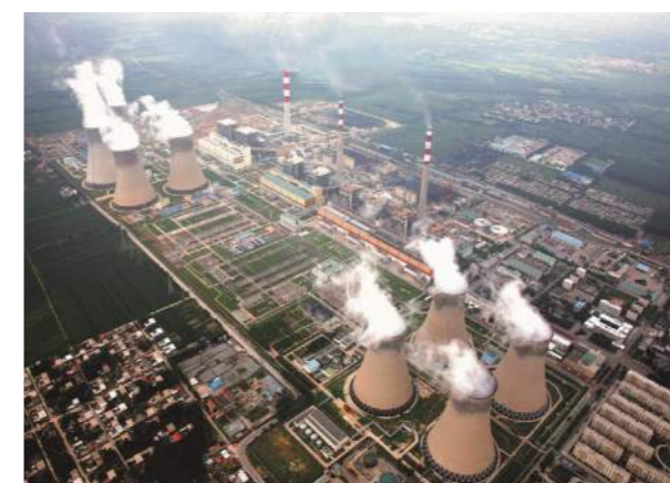
全面实施燃煤电厂超低排放和节能改造，全国累计完成燃煤机组超低排放改造7亿千瓦左右。图为山东省邹城市华电国际电力股份有限公司邹县发电厂超低排放改造后厂貌。
