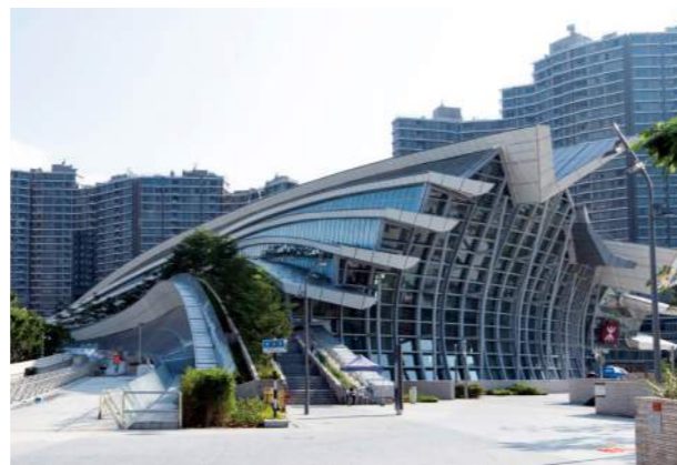
广深港高铁香港段全程26公里，于2018年9月建成通车，在香港西九龙站设立内地口岸区并实施“一地两检”通关安排。图为广深港高铁香港段西九龙站。
